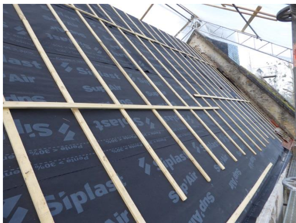
Pose du sous-toit
