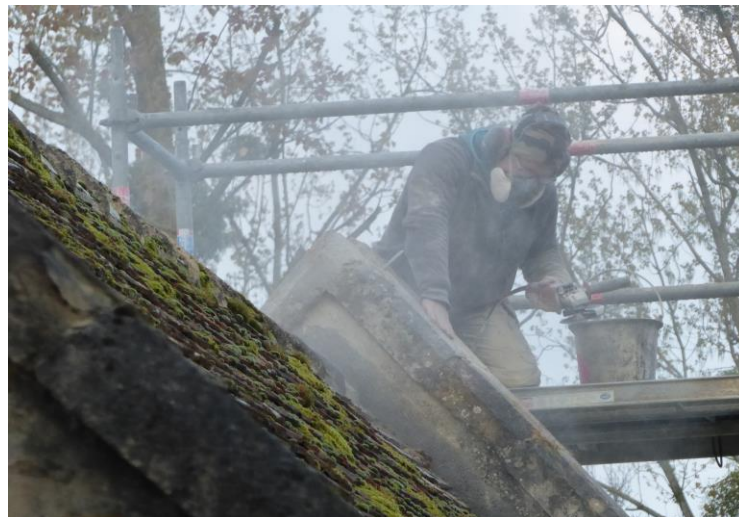
Grattage des joints de la façade occidentale
