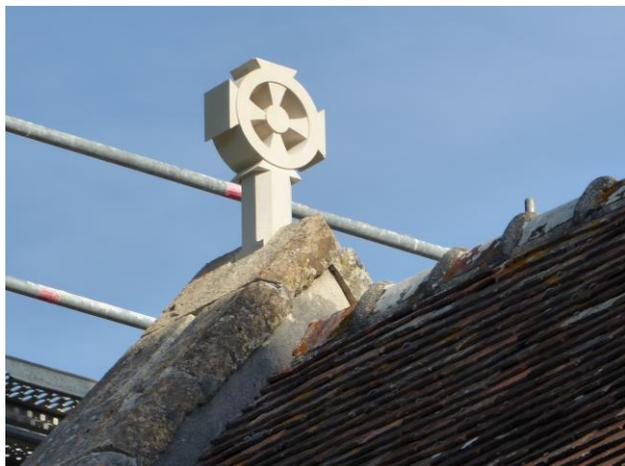
La toiture du chœur a été découverte, quelques bois de charpente furent remplacés, toutes les tuiles ont été examinées, les mauvaises jetées et remplacées par des nouvelles. La couverture a été replacée en ménageant des gouttières discrètes qui éviteront que l'eau de pluie stagne au pied des murs.
