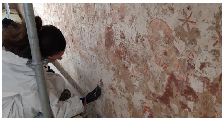
Dégagement d'une clochette du faux appareillage sur le mur sud
