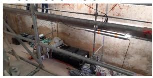
Les parties basses des murs de la nef ont été reprises avec un enduit de chaux mais celui-ci tarde à sécher du fait de l'humidité venant du sol. Leur coloration doit être reportée à fin août/septembre. L'échafaudage va être transféré dans le chœur dès fin août et les travaux de finalisation des scènes figurées seront effectués avec un échafaudage roulant.
